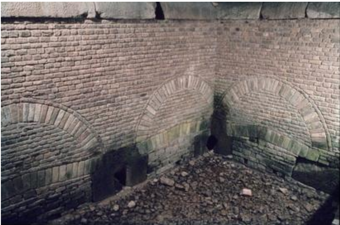
Brunnenstube Klausbrunnen in Mechernich-Kallmuth
