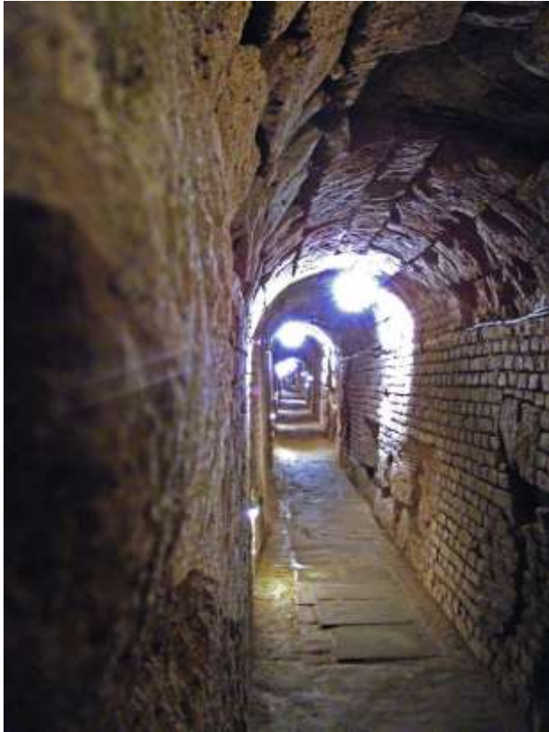
Der römische Abwasserkanal neben dem Prätorium
