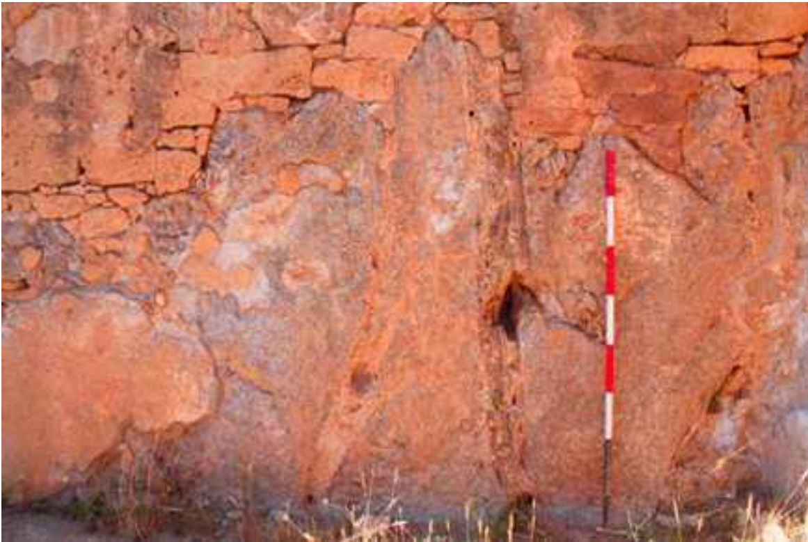
Fig. 1.6. Solonte, « Maison de Leda » - cat. maisons n. 11. Fracture naturelle du mont comblée par les concrétions calcaires.
