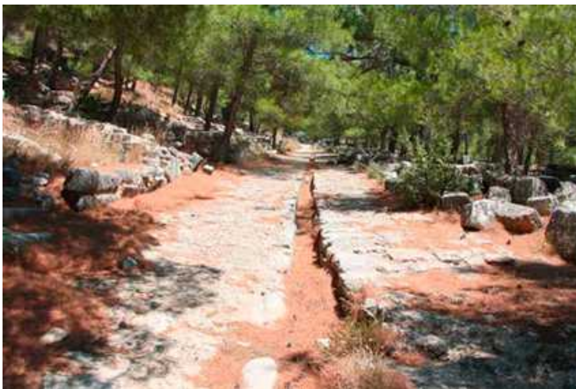
Fig. 4.47. Priène, rue de la Porte Ouest. Collecteur central, vu de l'Ouest.
