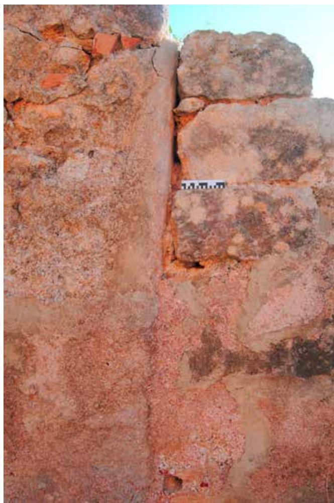
Fig. 3.3. Détail de la cloison séparant les citernes nn. 1 et 2 vue de l'Ouest.
