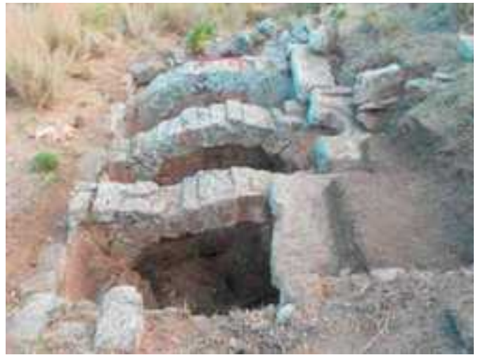
Fig. 3.27. Solonte. Citerne n. 75. Détail des arcs sur lesquels repose la couverture en dalles de pierre.
