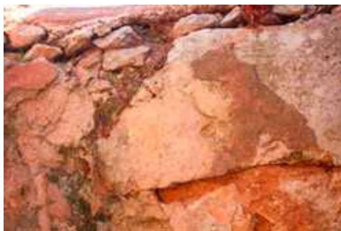
Fig. 3.25. Solonte. Citerne n. 33. Détail des mortiers imperméabilisants.
