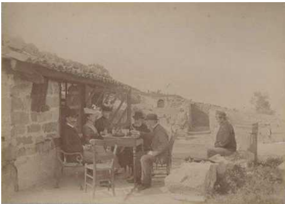
Fig. 2. Solonte. Visite du Duc D'Aumale des vestiges en 1883 (Archive du Musée Condé - m505205_ph-242-scan_p).
