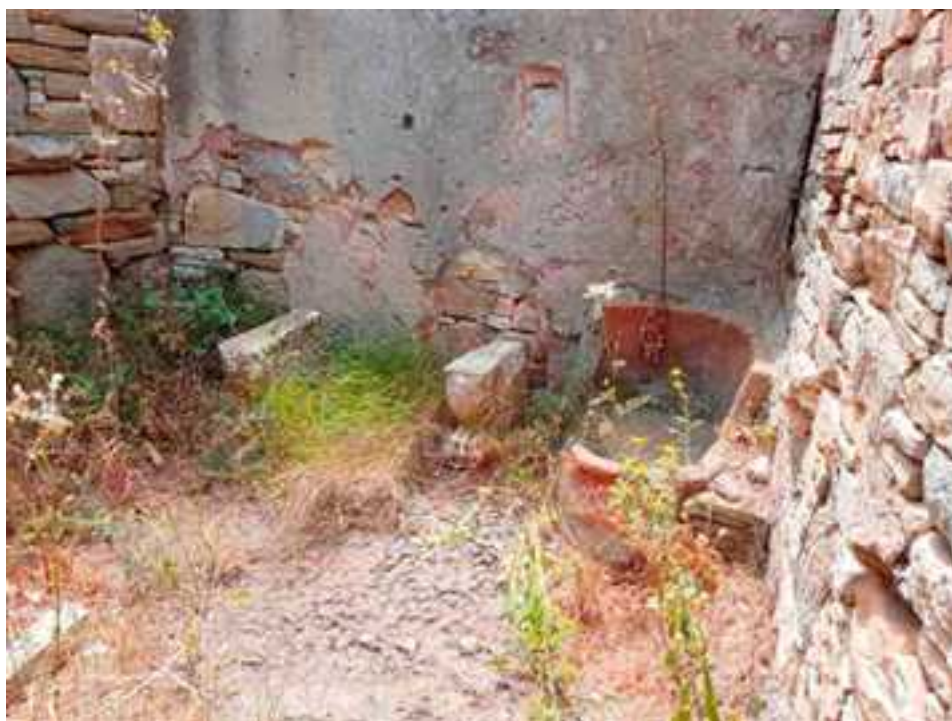
Fig. 4.52. Délos, Maison de l'Hermès. Pièce avec vasque à sabot en terre cuite. Vue du Sud.
