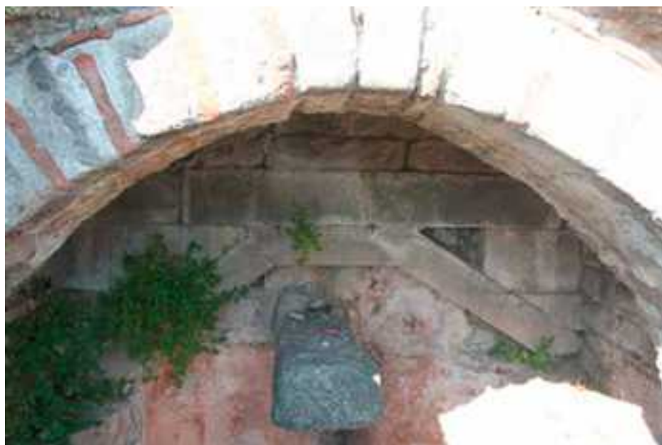
Fig. 4.41. Pergame, Acropole. Détail de trois systèmes de couverture successifs d'une citerne (1. poutre ; 2. bâtière ; 3. arc). Vue de l'Ouest.
