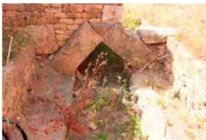
Fig. 4.24. Carthage, fouilles de Byrsa. Détail de couverture en bâtière d'une citerne.
