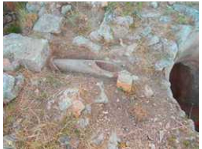
Fig. 3.56. Solonte. Citerne n. 45. Canalisat-ion d'évacuation en Tubular amphora vers l'ambitus au Sud.
