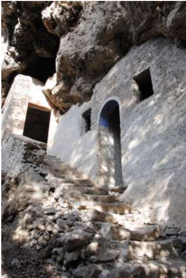
Abb. 1: Vicovaro. Abstieg zu den Leitungsabschnitten der Aqua Claudia und der Aqua Marcia vorbei an mittelalterlichen, in den Fels geschlagenen Kapellen.
