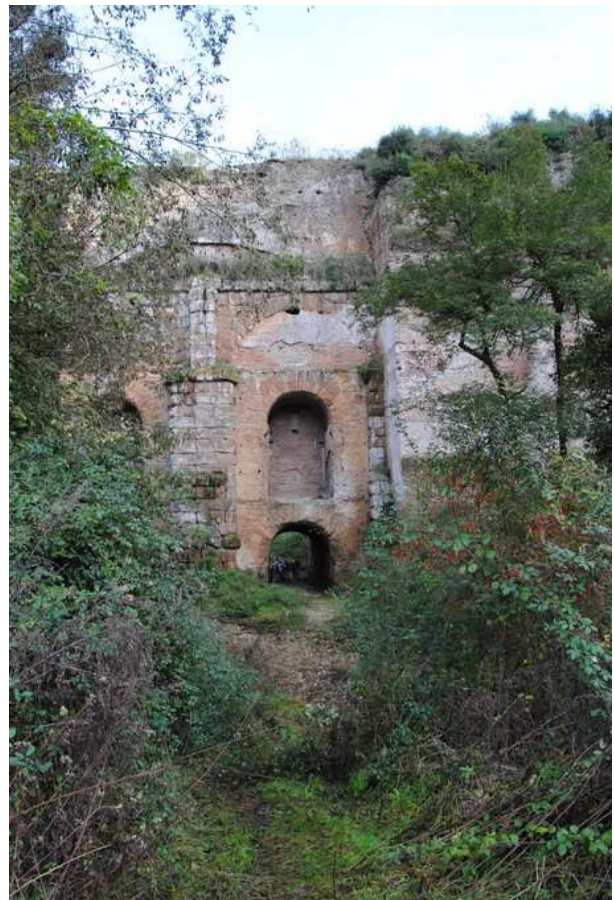
Abb. 2: Galliciano, Via Prenestina. Aqua Marcia. Ponte Lupo am Fosso dell'Acqua Rossa.
