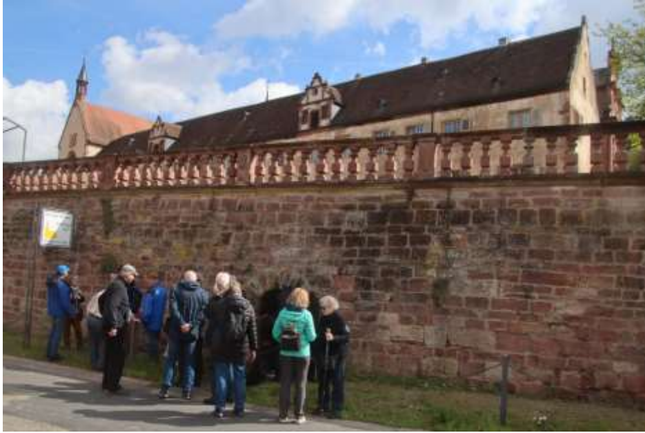
Einblick in den Auslass des Abwasserkanals
