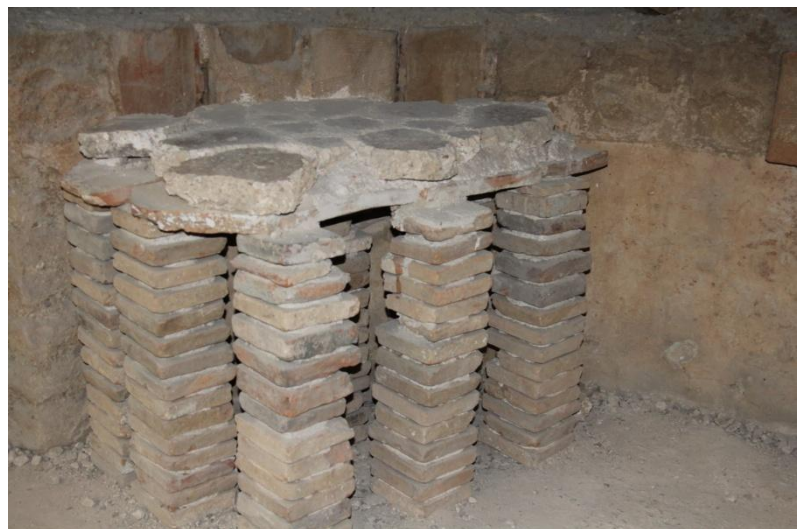
Hypokaustpfeiler mit darüber liegender Suspensur
