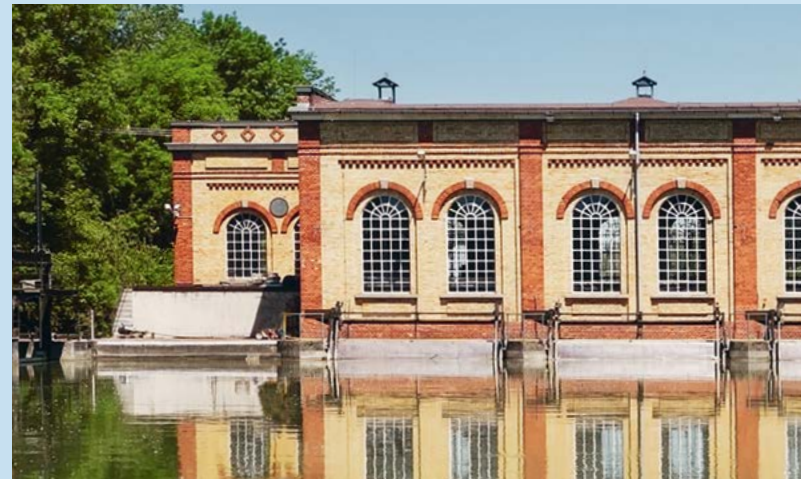
Kraftwerk an der Wolfzahnau
