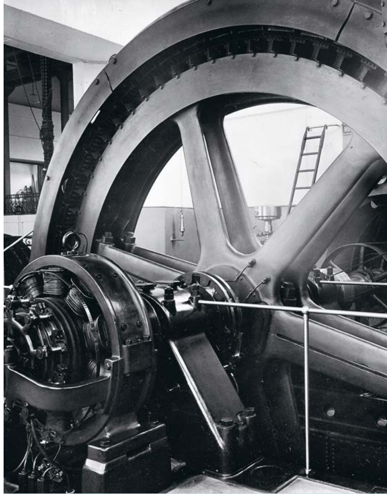
Schwungradgenerator im Kraftwerk an der Wolfzahnau
