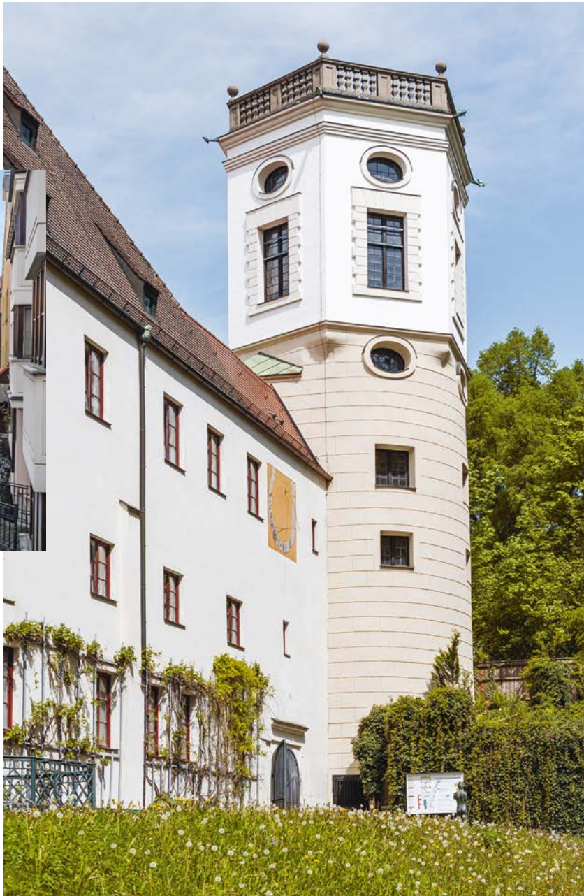
Kastenturm beim Wasserwerk am Roten Tor
