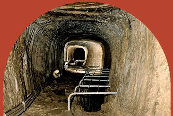
Blick in den Eupalinos-Tunnel auf Samos. Foto: Klaus Grewe
