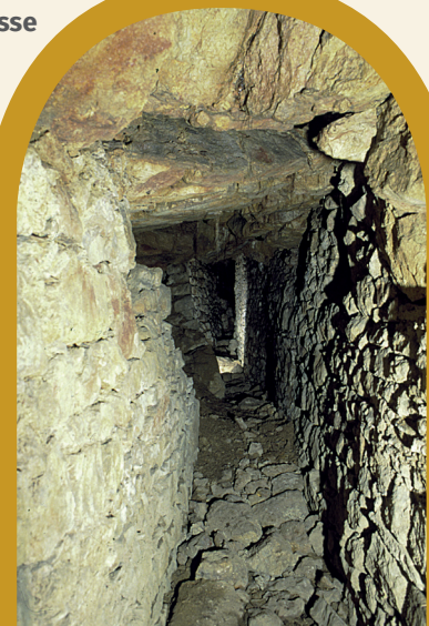
Blick in den Tiergartentunnel Blankenheim.
