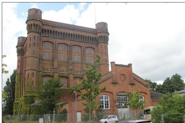
Wasserturm „Umgekehrte Kommode“
